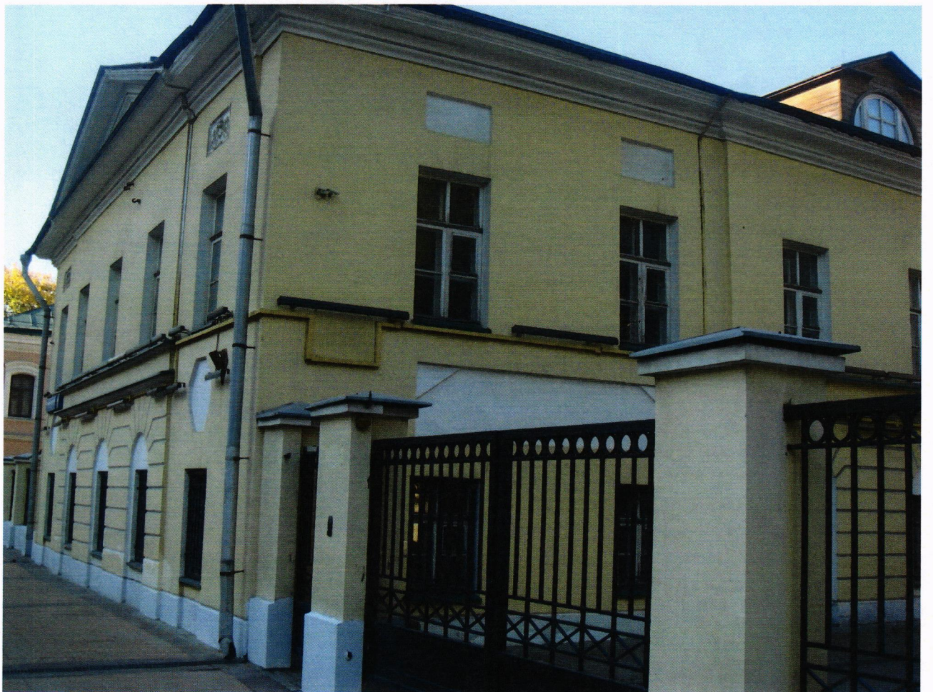
Фото № 4. Фасад западного флигеля со стороны Большой Никитской улицы.
