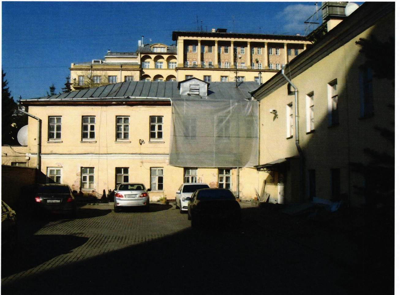
Фото № 6. Вид со стороны Большой Никитской улицы на корпус служб.
