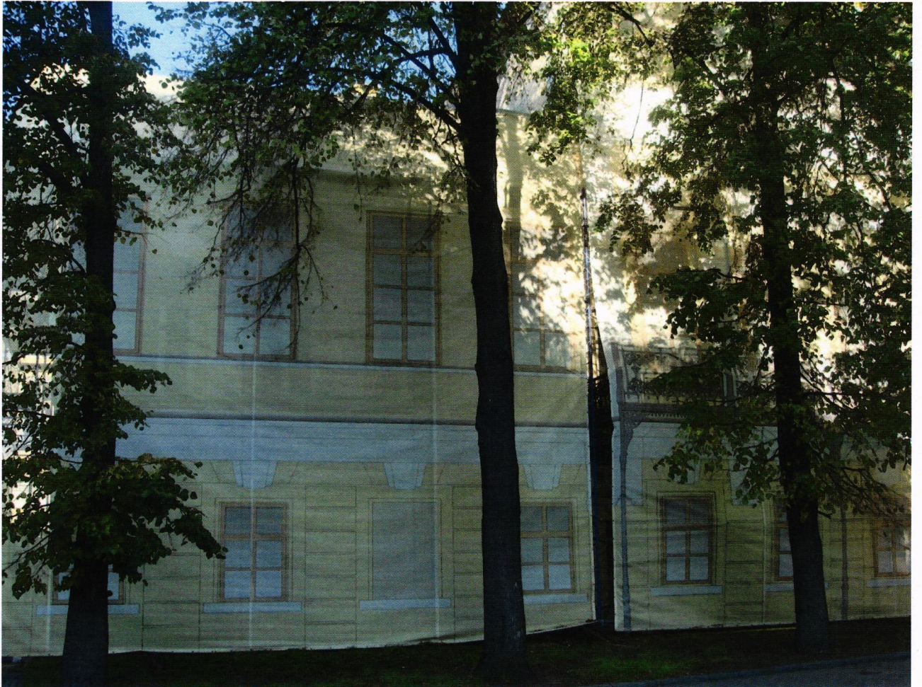
Фото № 1. Главный фасад со стороны Большой Никитской улицы.
