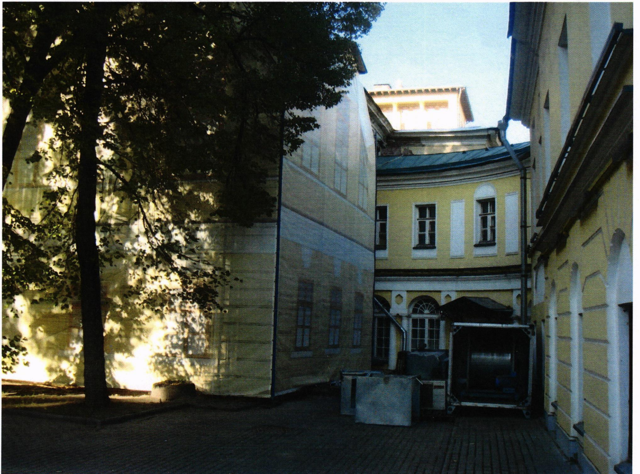
Фото № 2. Фасад восточного флигеля со стороны Большой Никитской улицы.
