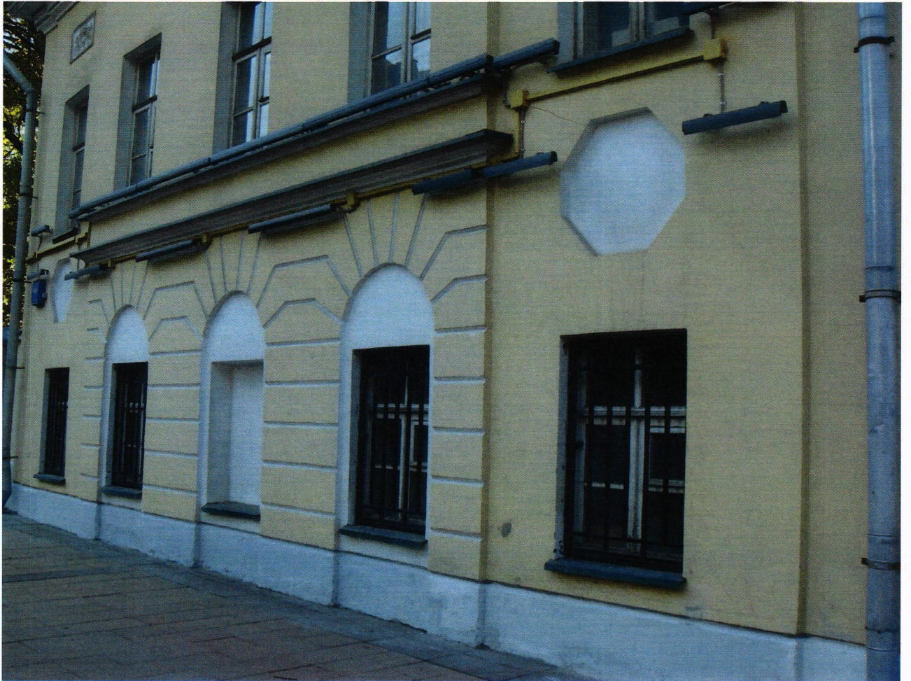
Фото № 3. Фасад восточного флигеля со стороны Большой Никитской улицы.
