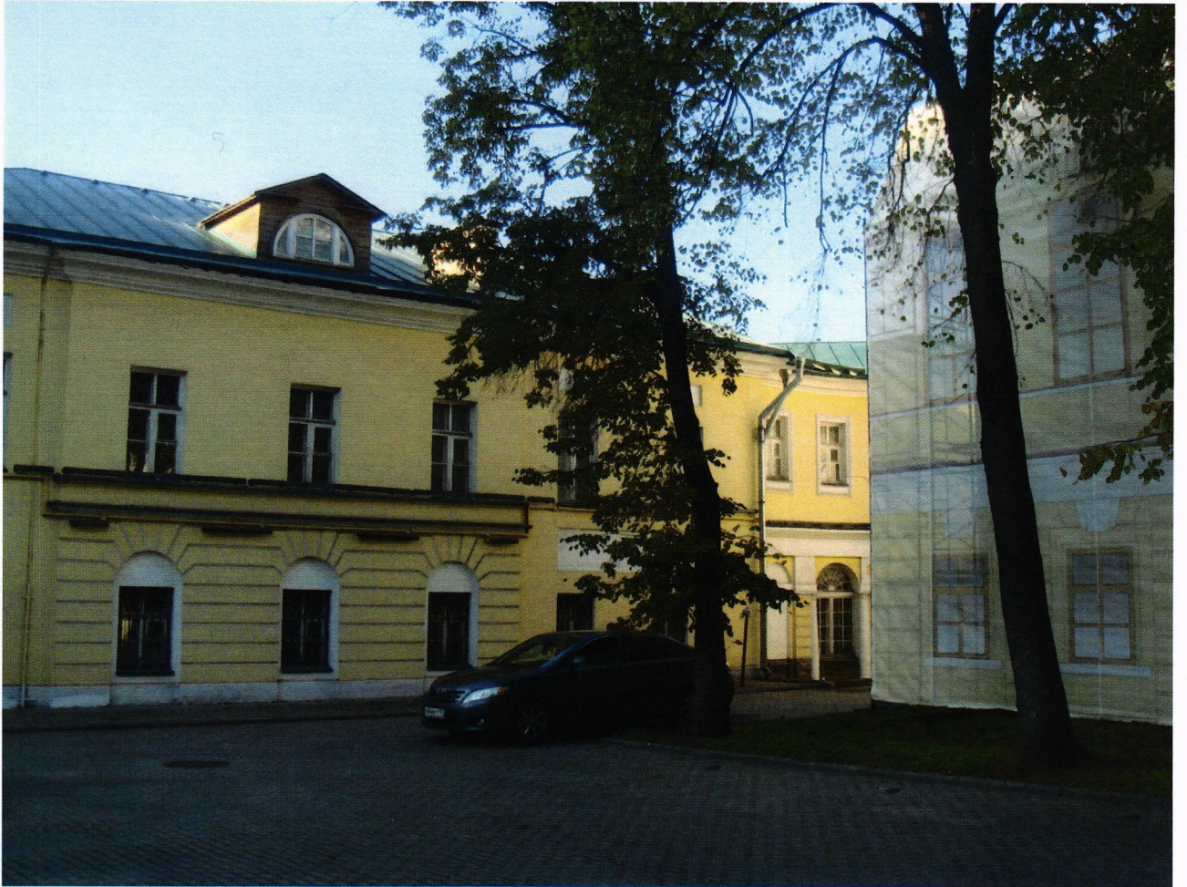
Фото № 5. Фасад западного флигеля со стороны Большой Никитской улицы.
